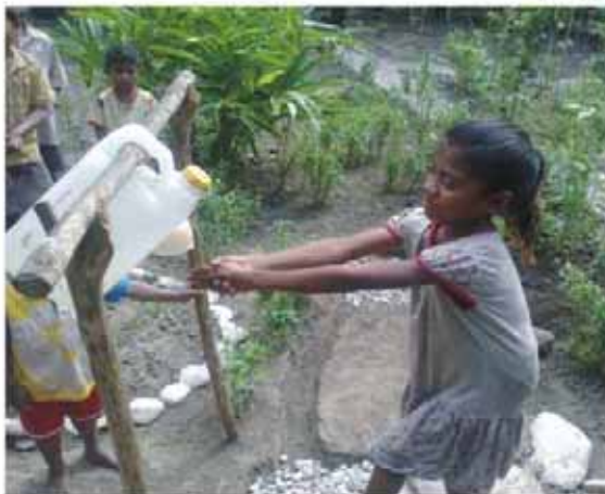
Tippy Tap (dengan saluran dan lubang resapan air dibawahnya), hasil buatan masyarakat sebagai sarana CTPS yang dipromosikan melalui program STBM foto: Plan Indonesia
